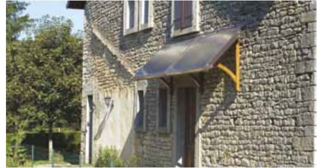
Les bâtiments anciens possèdent souvent des murs épais, avec une grande inertie thermique. Ils sont agréables à vivre en période de chaleur.
