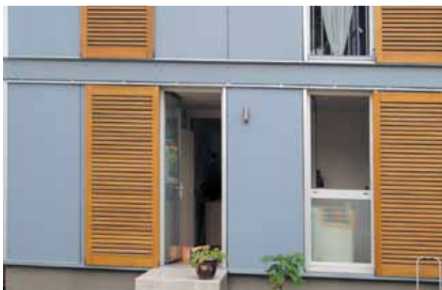
Persiennes, volets pleins, protections orientables, stores... : les protections de fenêtres sont très diversifiées et peuvent isoler de la chaleur comme du froid.
