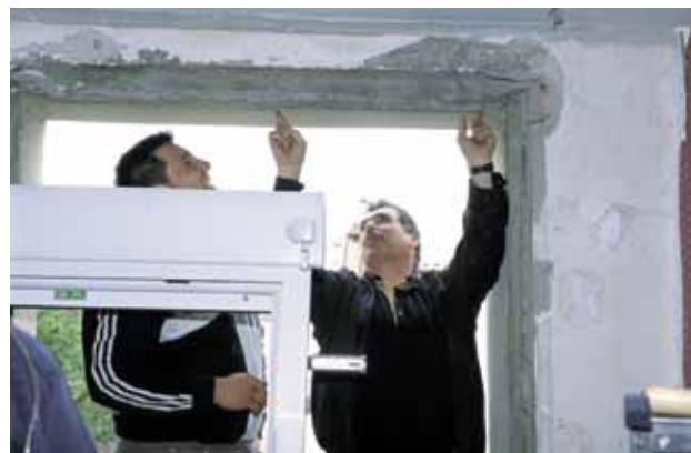
Pour le remplacement total de l'ancienne fenêtre, des travaux de maçonnerie sont à prévoir, mais le résultat obtenu sera performant.
